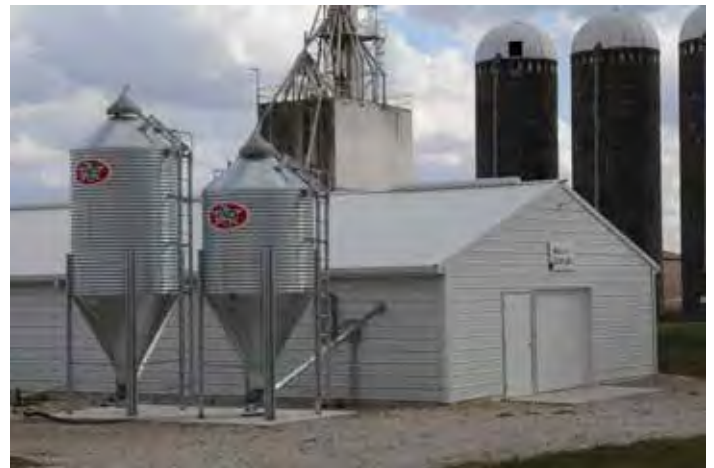
Figura 1.3. Las áreas de almacenamiento de la granja agrícola, incluidos los contenedores y ensilaje, pueden contener gases tóxicos o bajos niveles de oxígeno.
