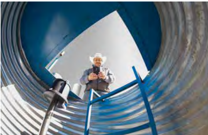
Figura 11.2. Un espacio confinado tiene medios limitados de entrada y salida. Para ilustrar, solo se puede ingresar a este pozo de irrigación usando la escotilla y la escalera. (Crédito: USDA)
