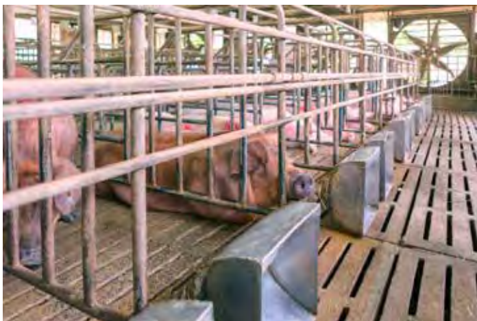
Figura 3.1. Los desechos animales se drenan a través de las rejillas del piso hacia los pozos de almacenamiento o canaletas debajo.
