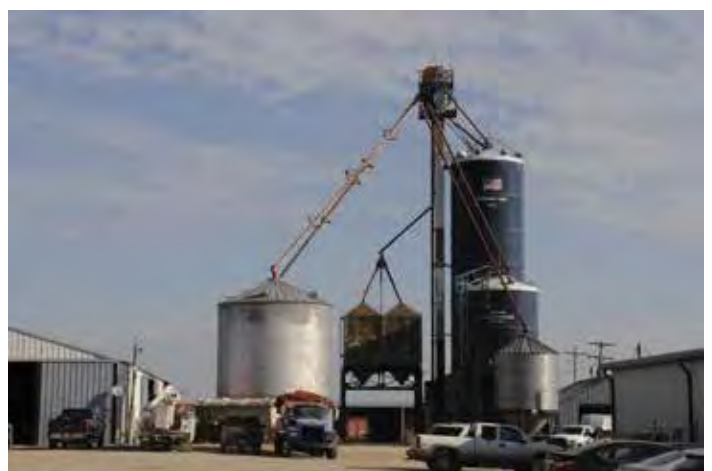
Figura 4.3. Las estructuras de almacenamiento de ensilaje pueden contener gases de fermentación peligrosos. Las estructuras de almacenamiento de granos pueden contener fumigantes.
