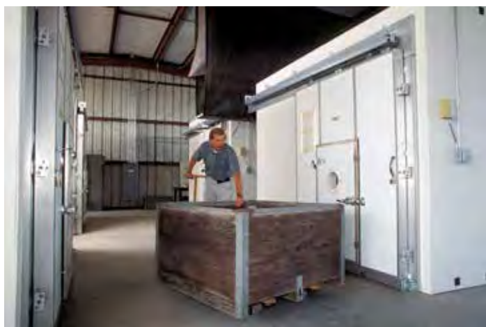
Figura 4.15. Las salas de almacenamiento de atmósfera controlada (las grandes cámaras blancas de la imagen) reducen los niveles de oxígeno para preservar los productos agrícolas. (Crédito: Agricultural Research Service)
