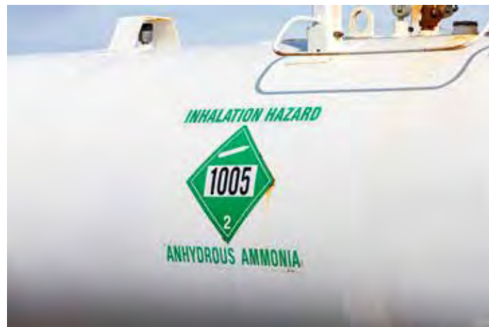
Figura 6.2. El amoníaco anhidro presurizado puede causar quemaduras químicas graves en el sistema respiratorio, los ojos, la boca y la piel.
