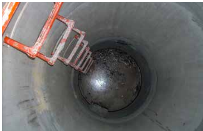
Figura 11.7. Un espacio confinado puede requerir permiso si tiene el potencial de una atmósfera peligrosa. Los espacios confinados subterráneos a menudo contienen bajas concentraciones de oxígeno o gases asfixiantes.
