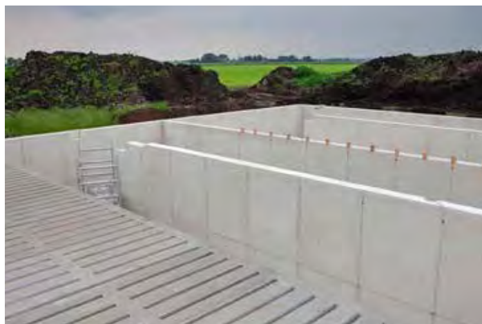
Figura 3.4. Este piso de granero está en construcción. Tenga en cuenta los profundos pozos de almacenamiento de estiércol directamente debajo de los pisos de rejillas.
