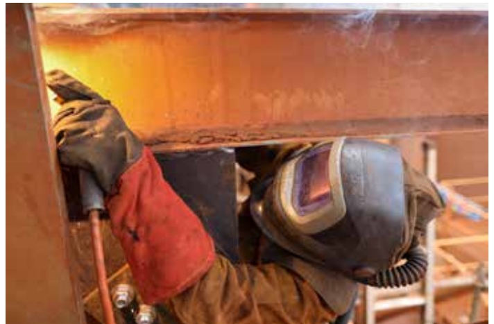
Figura 8.5. Este casco de soldadura tiene incorporado un respirador purificador de aire motorizado (PAPR, por sus siglas en inglés) para proteger al trabajador de los humos.
