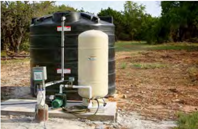
Figura 11.1. Un espacio confinado es lo suficientemente grande como para entrar completamente y trabajar en el interior. El tanque de almacenamiento negro de este pozo de agua es lo suficientemente grande como para entrar. Por lo tanto, puede considerarse un espacio confinado si también tiene entrada/salida limitada y no está diseñado para una ocupación continua. Por el contrario, el tanque de presión de color claro no es un espacio confinado porque es demasiado pequeño para entrar y trabajar en su interior.
