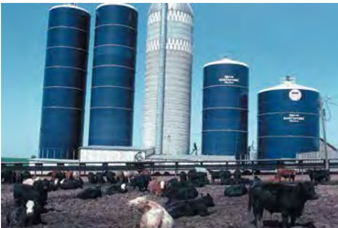
Figura 4.9. Los ensilajes limitadores de oxígeno verticales (azul en la imagen) normalmente se cargan desde la parte superior y se descargan desde la parte inferior. Están diseñados para mantener un ambiente casi hermético. (Crédito: Lynn Betts, USDA Natural Resources Conservation Service)
