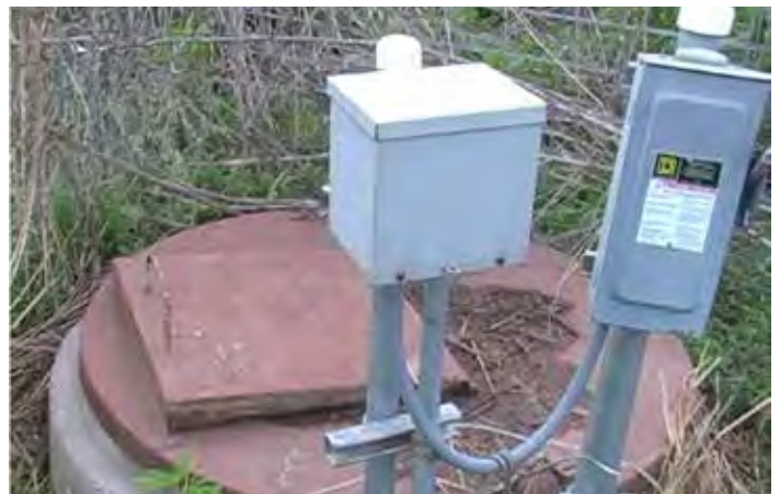
Figura 4.2. Los niveles bajos de oxígeno y los gases peligrosos son comunes en los pozos de agua y las cisternas.
