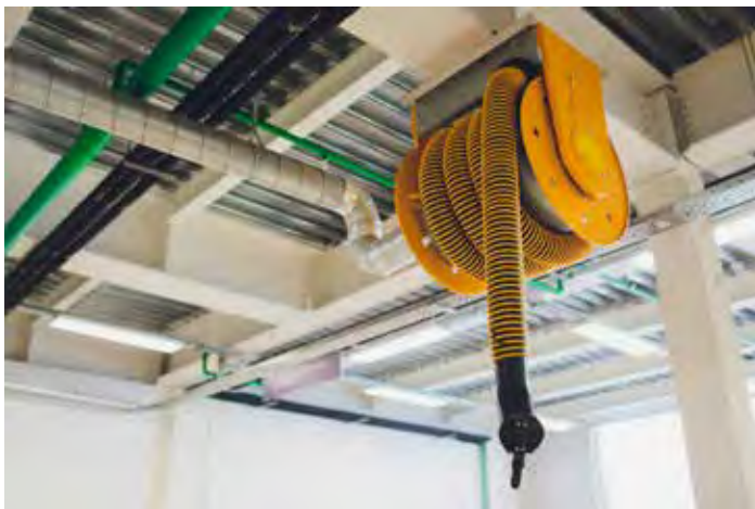
Figura 7.10. Los sistemas de tubos de escape utilizan ventiladores y conductos para capturar el escape de gases del vehículo.
