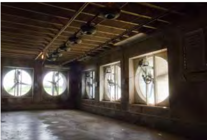
Figura 13.2. Los sistemas de ventilación bien diseñados reducen los contaminantes en el aire en los establos de ganado. (Crédito: USDA)
