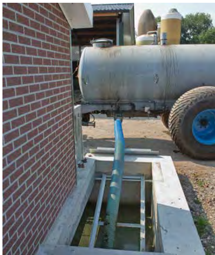
Figura 3.9. Pozo de estiércol subterráneo siendo bombeado. Las concentraciones de gases tóxicos pueden aumentar en las áreas ocupadas de los establos cuando los desechos se vacían, agitan o bombean.
